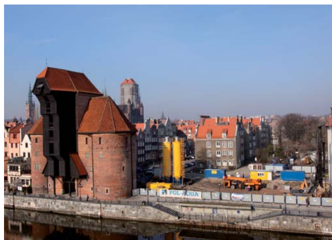
Stan budowy na 30 marca. Fot. Bernadeta Galus
